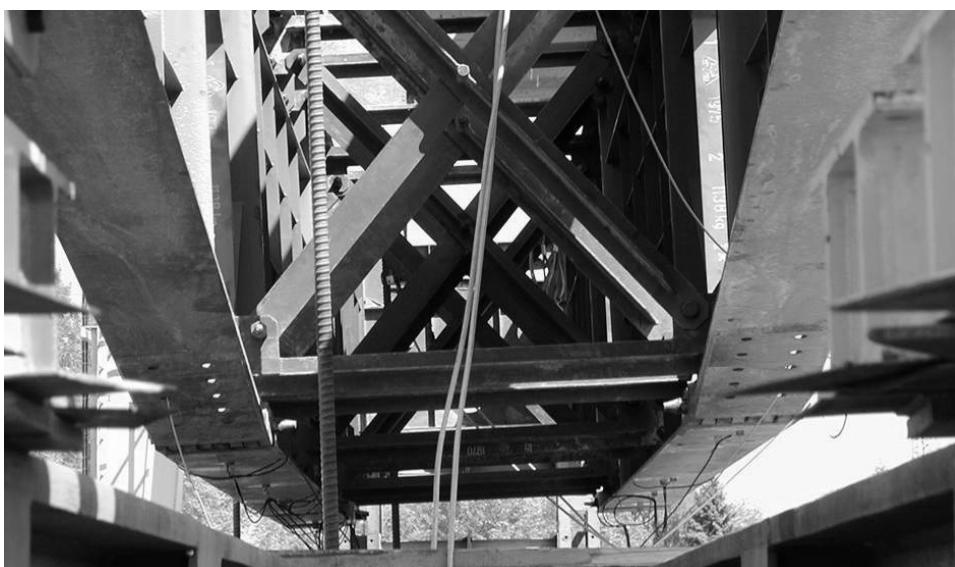
Obr. 2.: Sestava mostu ŽBM pro rozpětí 18 m – příhradové příčné ztužení
