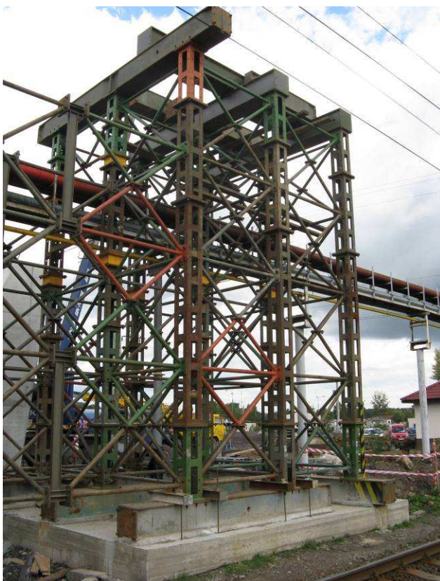
Obr. 2.: Vnitřní strana pilíře MP04 je tvořena 9 sloupků ztuženými ve svislých rovinách s vynecháním ztužení pro průchod stávajícím vedením pilířem.
