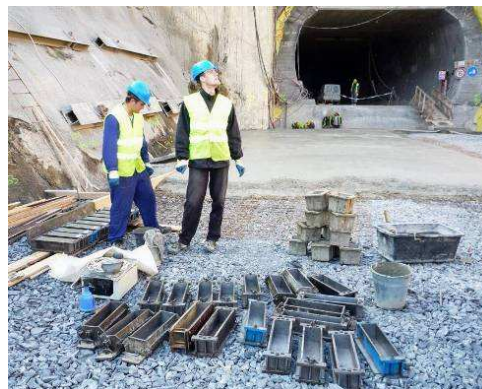
Obr. 2.: Výroba zkušebních vzorků druhé sady při betonáži portálu tunelu Dobrovského.
