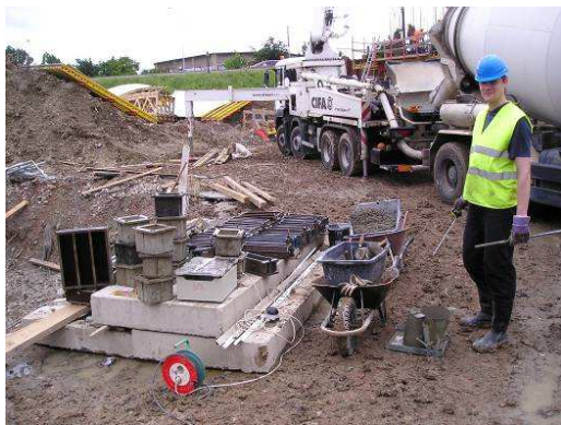
Obr. 1.: Výroba zkušebních vzorků první sady při betonáži pilíře mostu na ulici Sportovní.
