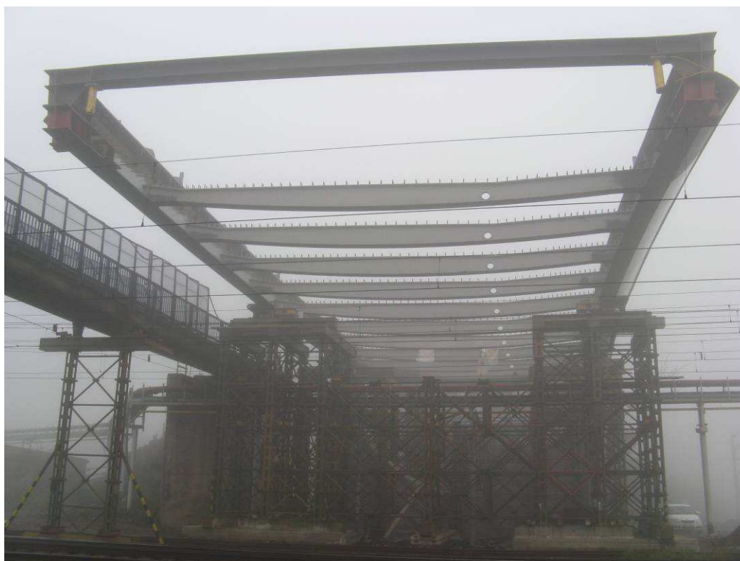
Obr. 1.: Vysouvaná konstrukce nad MP4. Vnitřní analyzovaná strana pilíře je na obrázku vpravo. Stav výsunu ráno 2.dne 1.etapy.
