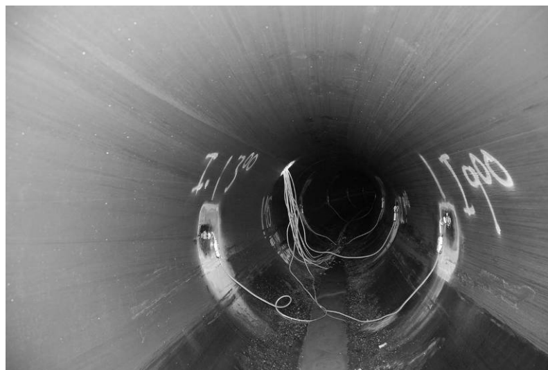
Obr. 10 Osadenie tenzometrov
