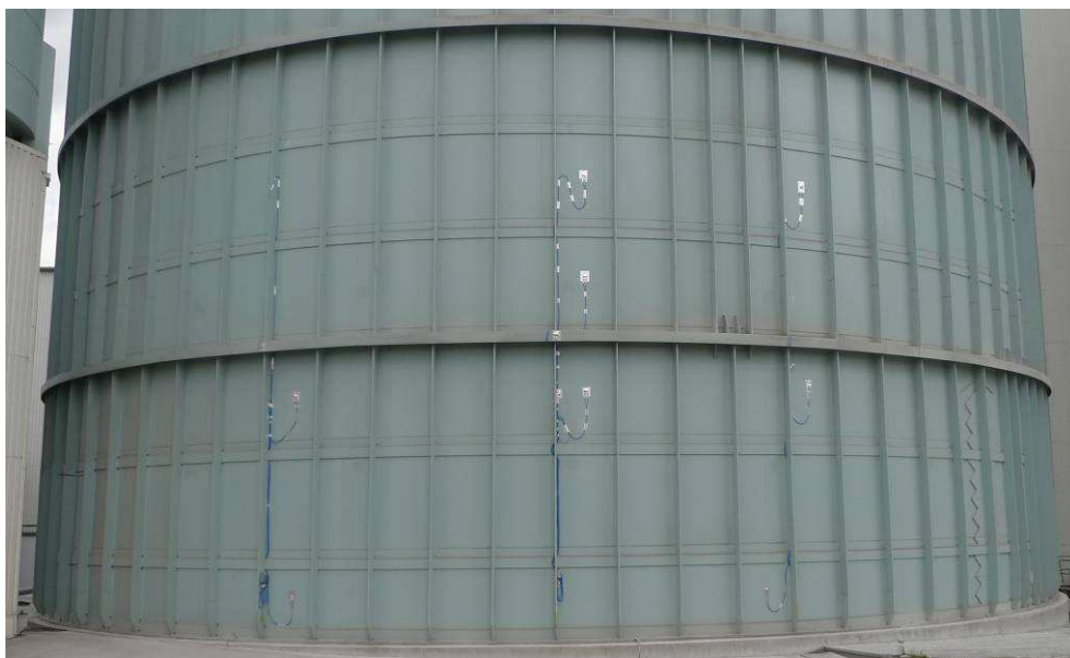
Obr. 1 Pohľad na nainštalovanú tenzometrickú aparatúru
