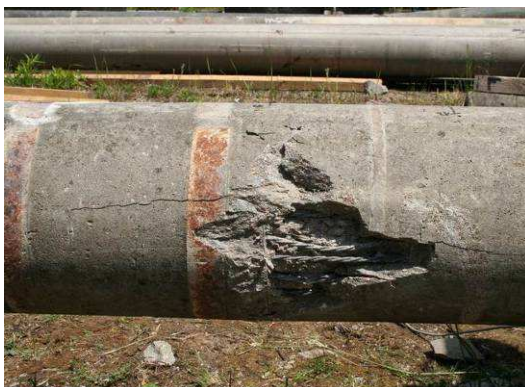
Sloup S4 – detail porušené oblasti
