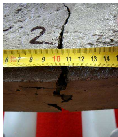
Obr. 10.: Detail trhliny – jasně patrné posunutí trubky v betonu.
