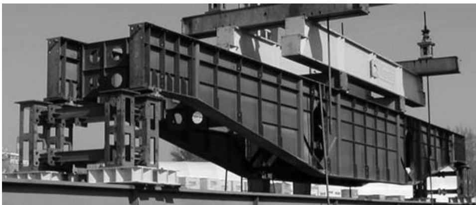
Obr. 1.: Sestava mostu ŽBM pro rozpětí 18 m – pohled na dvojici hlavních nosníků a podpory z prvků systému PIŽMO
