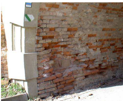
Obr. 2.: Pohled na levou část klenby směrem od jižního portálu tunelu
