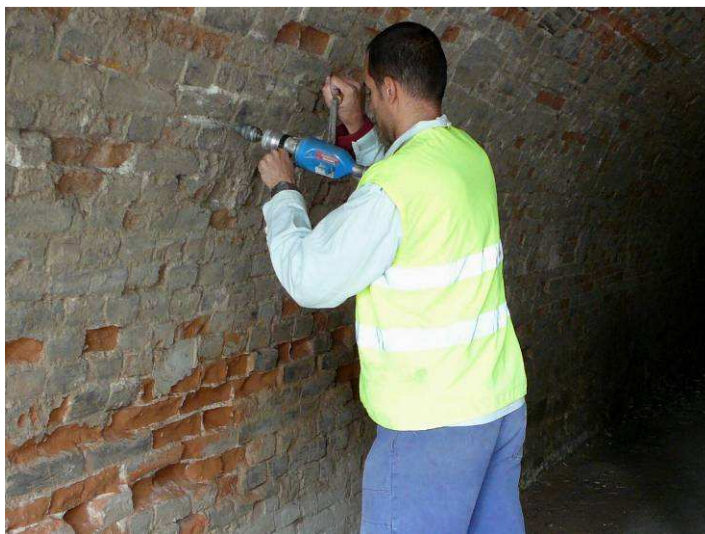
Obr. 11.: Zkoušení pevnosti malty v tlaku Kučerovou vrtačkou
