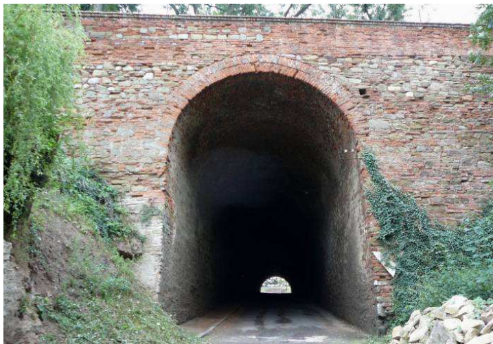
Obr. 1.: Pohled na severní portál tunelu pod zámeckým parkem
