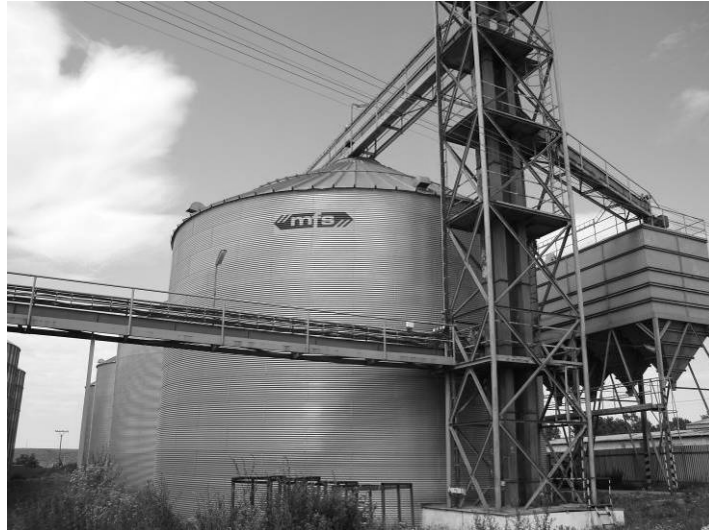
Obr. 14 Silo z vlnitého plechu na repku
