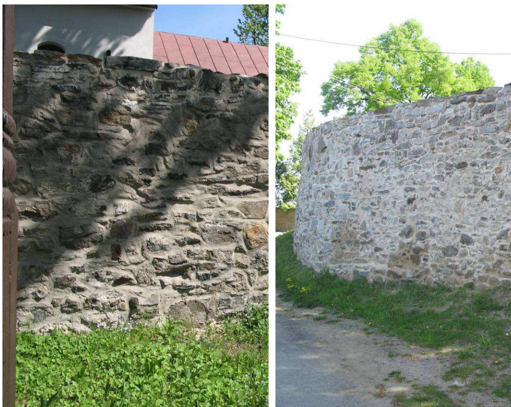
Obr. 1.: Hřbitovní zeď kostela sv. Václava v Chlumu před opravou (vlevo) a po opravě (vpravo)
