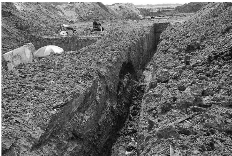
Obr. 11 Trhliny v zemi nadložia
